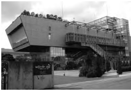
電力設備、空調設備など館自体が環境技術の生きた展示となっている環境エネルギー館。愛称は、ワンダーシップ。子どもたちの不思議に思う心を乗せ、未来へ出航。
