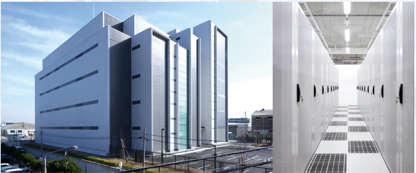
万全のセキュリティ、災害にも強いデータセンターに弊財団サーバを設置し、各種 Web システムを開発から運用までトータルでご提供しています
