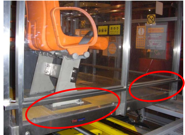
写真 2 地震免震装置のカゴ下部の隙間塞ぎ
