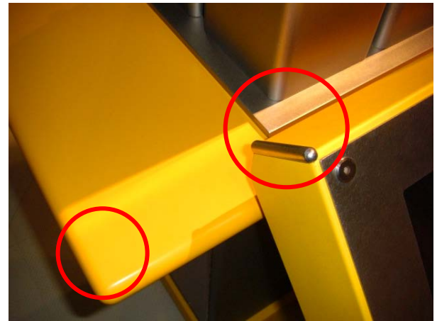
写真9 角部のR面取りと出隅部の丸鋼溶接
