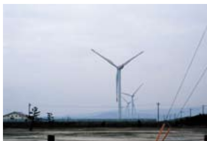
【大型風力発電施設見学（北栄町）】 ゆったりと回る風車も、羽の先端は時速 250km にもなると聞いてびっくり
