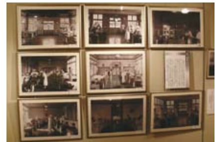
【重病室内の様子を写した写真】
