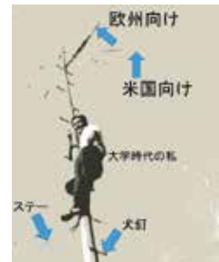
大学時代。終戦後に短波の受信が解禁され、自宅裏にアマチュア無線用の短波アンテナを建設した
