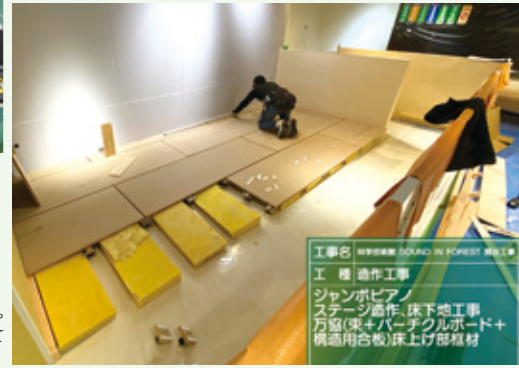
「ジャンボ・ピアノ」部分の床上げ。安全性や階下への振動について入念な検証を繰り返して実現
